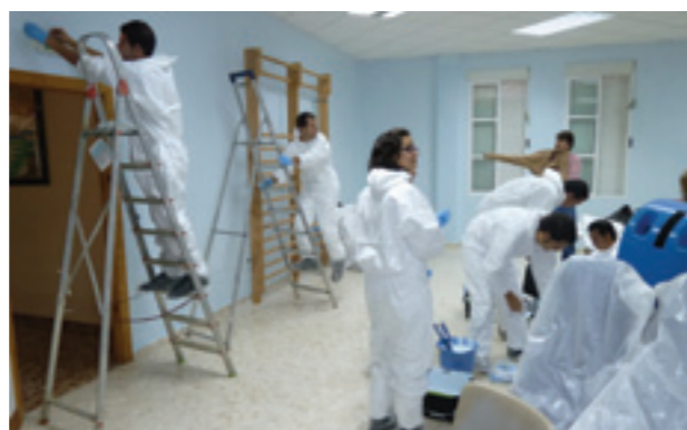
Renovación del centro de discapacitados
