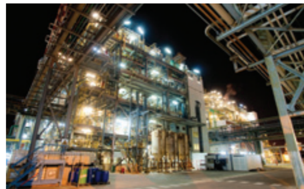
Planta de Catalizadores del centro de Tarragona
